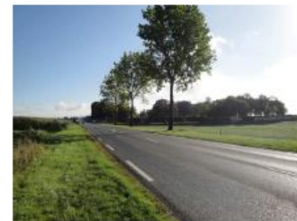
Alignement d'érables sycomores le long de la RD929.
