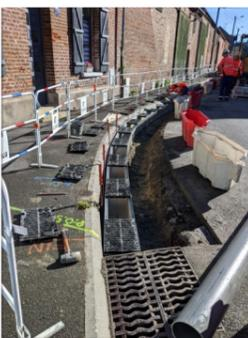
Afin de préserver les habitations lors de fortes pluies, un caniveau est réalisé rue Victor Mauduit afin de capter et canaliser les eaux pluviales. Le montant des travaux s'élève à 60 000 euros.
